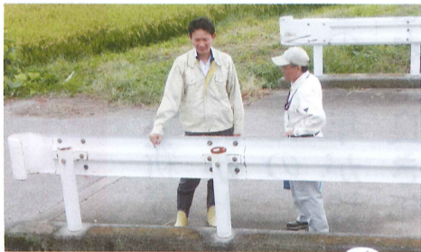
農業用水改修の説明を聞く
