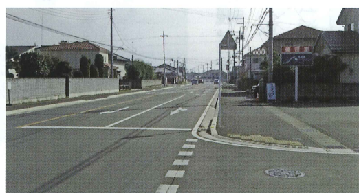
経済を支える幹線道路を整備します。
