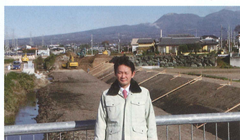
豪雨に備えて河川改修を進めます。
